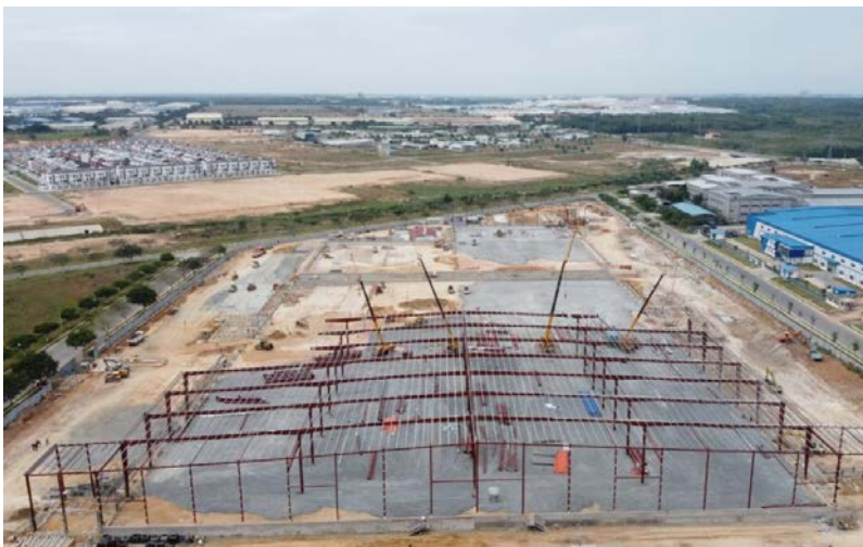
BW7 - BW Industrial KCN VSIP 2A, Bình Dương
